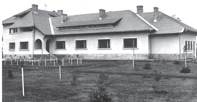
I.C.A.R. - Clădirea administrației și laboratoarelor, în 1940. Colecția foto: Gheorghe Ivașcu
